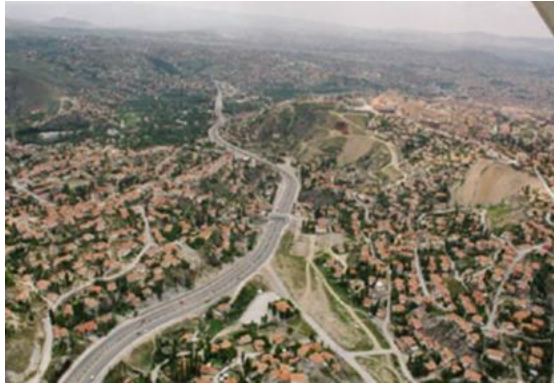
Şekil 1. KAP'ın Yıkım Öncesi Görüntüsü ve Mevcut Durum [6]
