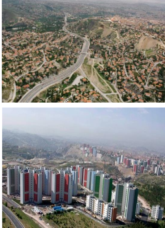
Şekil 1. KAP'ın Yıkım Öncesi Görüntüsü ve Mevcut Durum
